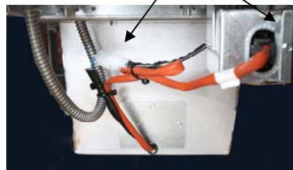
Figure 3: Enchufe los conectores blancos de dos patillas y enchufe el conector negro en la caja de suministro eléctrico tal y como se muestra en la ilustración.
